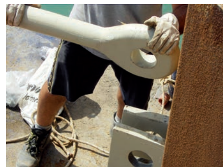
Анкерные штанги с лакокрасочным покрытием
