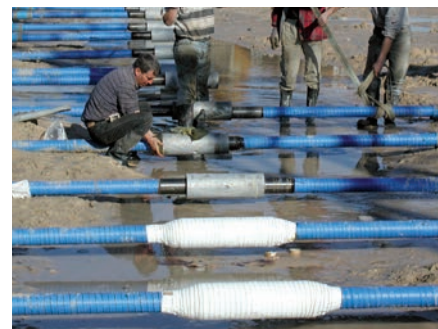
Нанесение антикоррозионной ленты/пленки на соединения анкеров в полевых условиях
