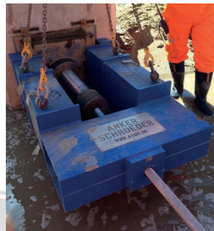
Операция по созданию преднапряжения
