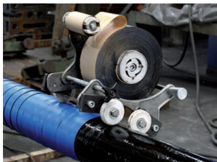
Заводское покрытие анкера антикоррозионной лентой
